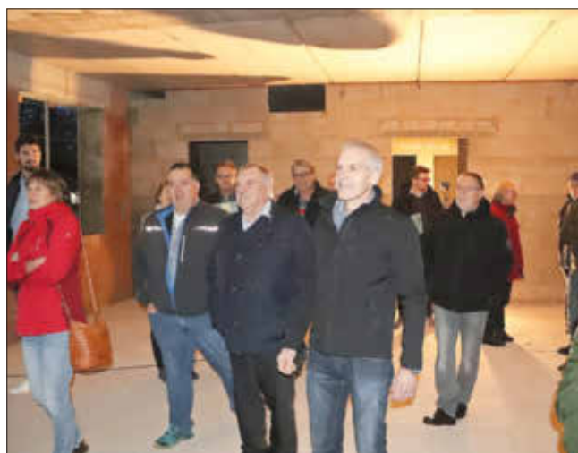
Das „Innenleben“ der noch im Rohbau befindlichen neuen Sporthalle in Weyerbusch wurde von den Mitgliedern des Sportausschusses der Verbandsgemeinde Altenkirchen besucht.
