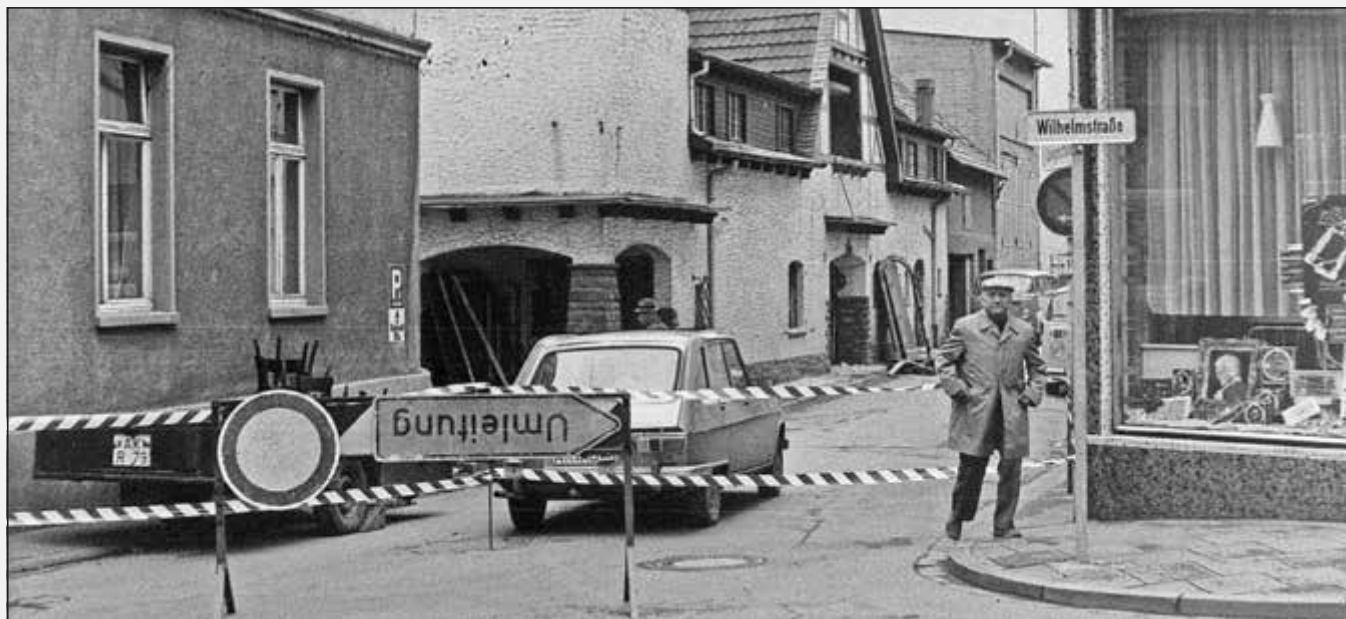
Blick in die Quengelstraße; das Kino (Bildmitte) wird abgerissen.
